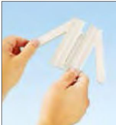
팬랩 작업 공구를 열어 케이블 번들을 삽입한다.
