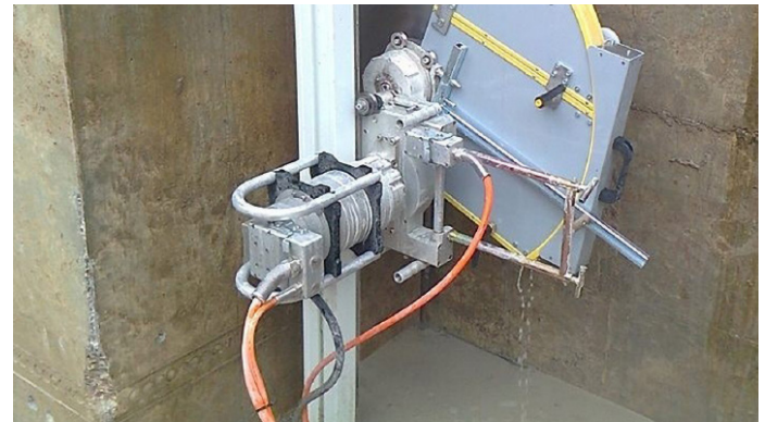
Betonsägemaschine / Concrete saw
